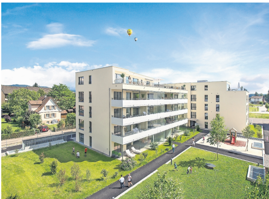
Die Wohnhäuser bieten alle einen Blick auf den grosszügigen Innenhof.
